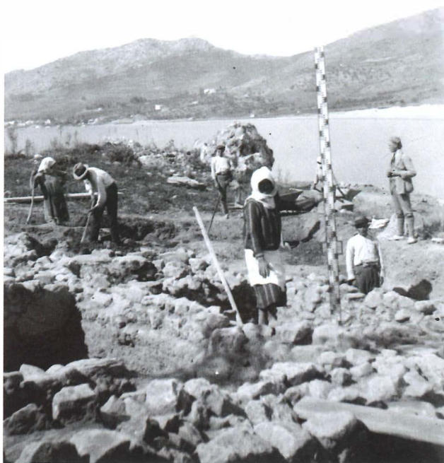
Höjdavvägningar i Lågstaden, 1926. För att kunna rita nödvändiga planer och sektioner använde man modern utrustning, som teodoliter, för att mäta höjdavstånden. Här håller en kvinna med vit huvudduk i mätstaven, den så kallade "lattan", medan flera män jobbar i bakgrunden. Till höger syns en av arkeologerna. Foto: Asinesamlingen (c8310).
